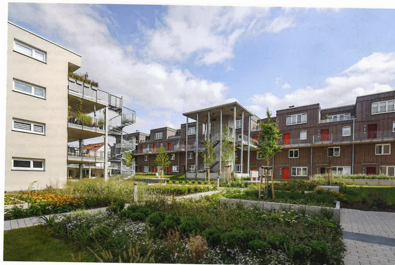
In den Fehrle-Gärten in Schwäbisch Gmünd hat die Landes-Bau-Genossenschaft Württemberg eG auch ein Ärztehaus errichtet – eine Antwort auf den vorhandenen Bedarf
